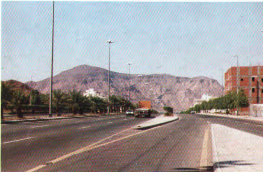
(٤) (جماع عاقر) صورة لجماع العاقر من الجهة الشرقية وقد تصدرت واجهة الطريق من الجهة الغربية .
