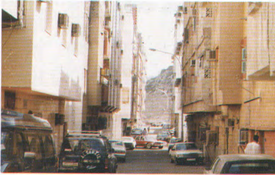
(١٢) (جبل سلع) صورة تمثل النهاية المغلقة حد الشوارع المتجهة من الشرق إلى الغرب المنظمة داخل الشعب الشرقي لجبل سلع.
