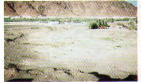
(١٨) (وادي قناة) مسار وادي قناة في منطقة انحرافه جنوب منطقة سيد الشهداء قبل إخضاعه لأعمال الصيانة والتحسين.
