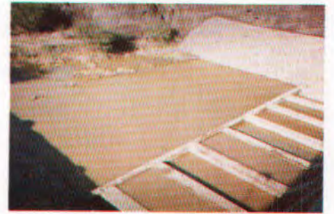
(١٠) (وادي بطحان) بعض الحوائط الاستنادية التي أقيمت على جانبي الوادي عند خروجه من السد لحماية المناطق المجاورة .
