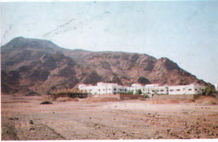
(٦) (جماء أم خالد) بعض المباني والمنشآت المقامة عند الطرف الشمالي الغربي لجماء أم خالد والتي بنيت ضمن مخططات معتمدة.
