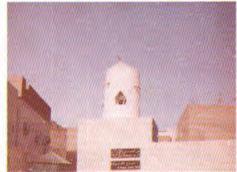
(٦٦) (جبل سلع) مسجد بني حرام الكبير والذي يقع في شعب بني حرام غربي سفح جبل سلع.
