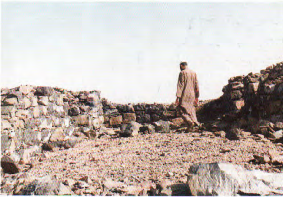
(٧٢) (جبل عير) صورة لبعض أطلال وبقايا المباني والمنشآت الحربية على جبل عير (٣) .
