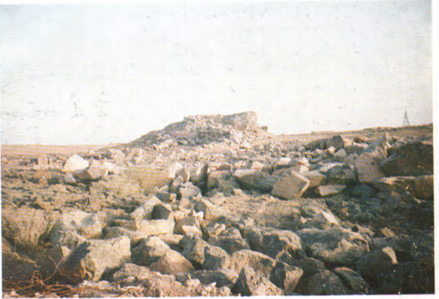
(٢٧) (وادي الرانونا) صورة تمثل تناثر الكثير من حجارة السد نتيجة انهيار بعض أجزائه.
