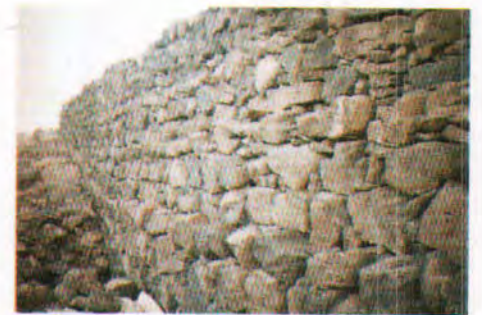
(١٦) (وادي الرانوناء) صورة لبعض أجزاء السد ويظهر التدرج الهرمي للبناء.
