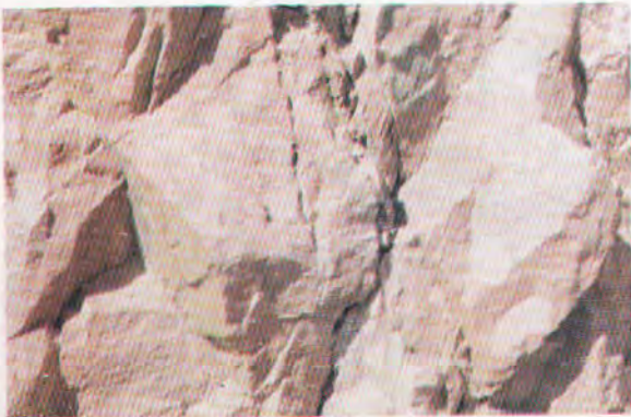
(٣٩) (جبل الحرم) صورة لأحد أجزاء الصخور الشرقية المطلة على التجويف الكبير لجبل الحرم الأكبر وتظهر بعض حفر الألغام النارية التي استخدمت في عملية التكسير.
