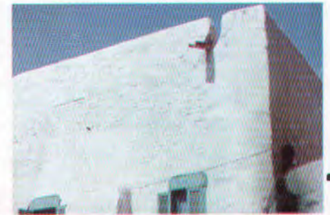
(٧٣) (جبل سلع) الواجهة الجنوبية لمسجد الراية على جبل الراية .
