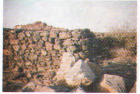
(٢٨) (وادي الرانونا) تهدم بعض أجزاء سد الرانونا نتيجة تعرضه لانحدار مياه الوادي المستمره دون إخضاعه للترميم أو الإصلاح .
