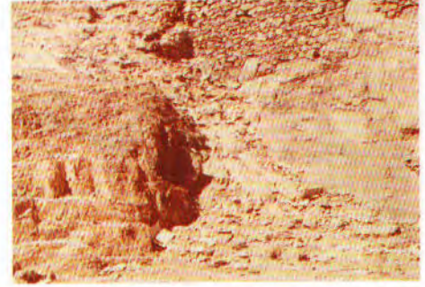
(١٣) (جبل عينين) صورة للشعب الشمالي وقد طمر جزء كبير منه بالأتربة ومخلفات البناء .
