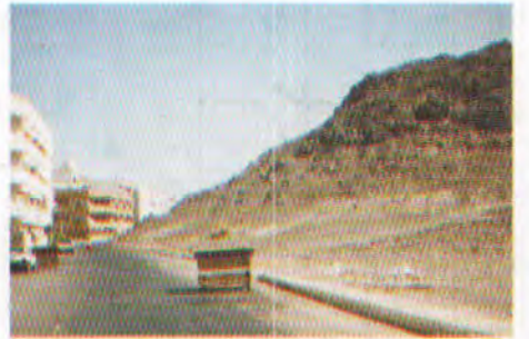
(٤٠) (جبل سلع) أحد الطرق الصغيرة التي نفذت لحماية الجبل من الجهة الشمالية .
