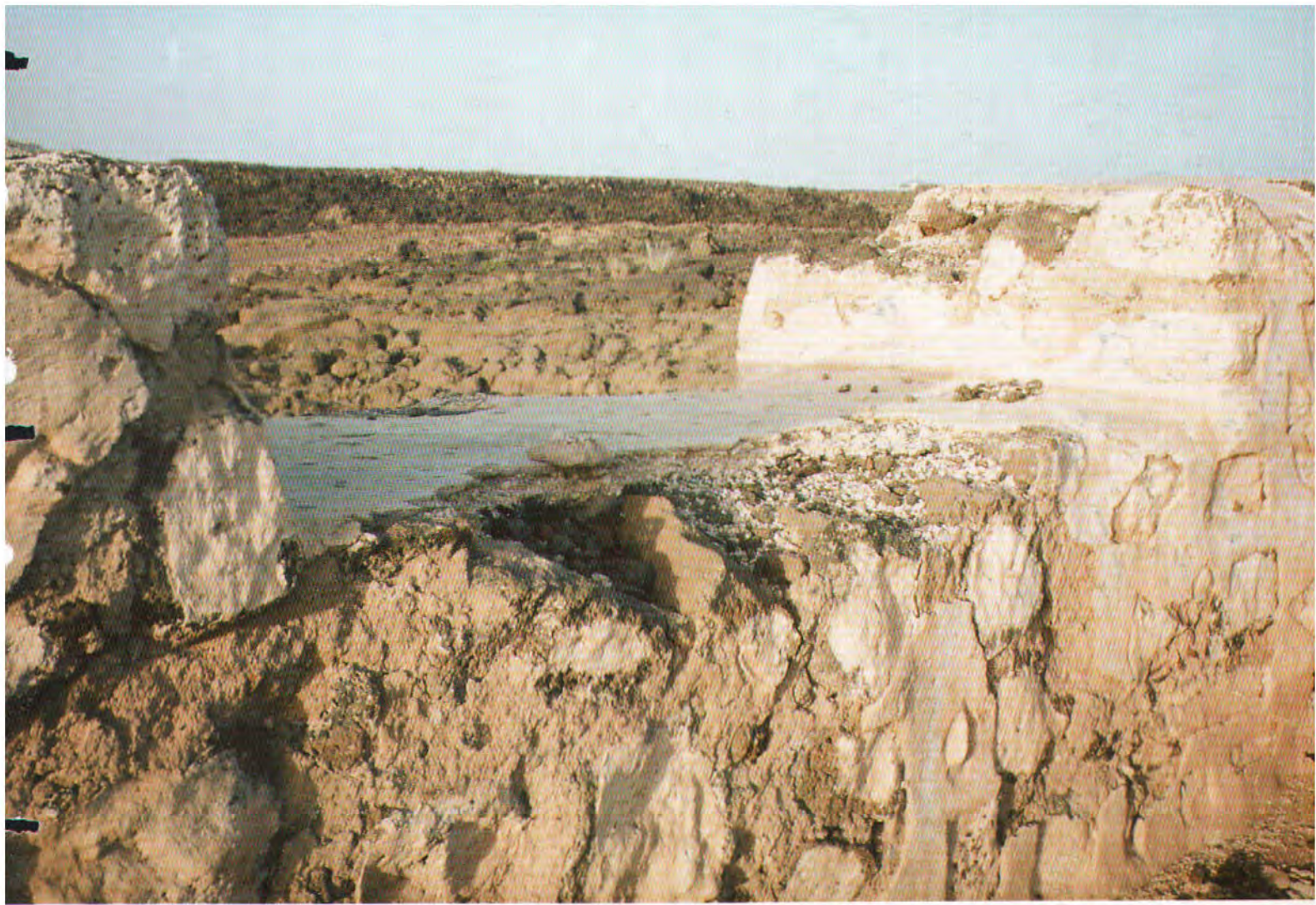
(١٢) (وادي الرانوناء) مخرج مياه السد وقد تم ترميمه باستخدام الجص والنورة.
