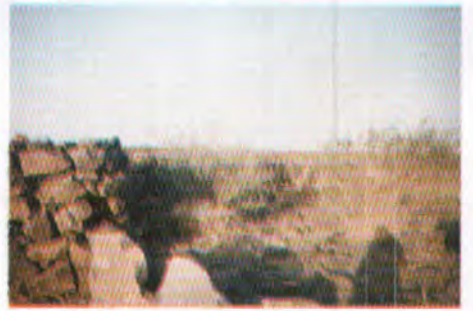
(٢٠) (وادي الرانوءاء) استخدام حجارة الحرة السوداء ذات الأحجام المختلفة أحد سمات البناء الرئيسية للسد .
