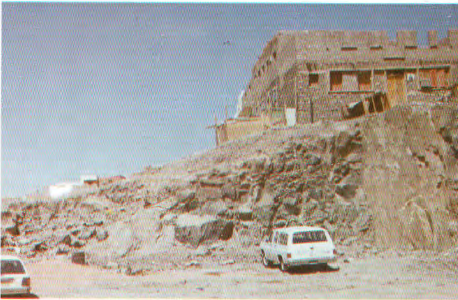
(٩) (جبل الراية) صورة لجبل الراية وقد أزيلت بعض أجزائه بهدف إنشاء المباني .
